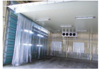
軟質ビニールカーテン施工事例
